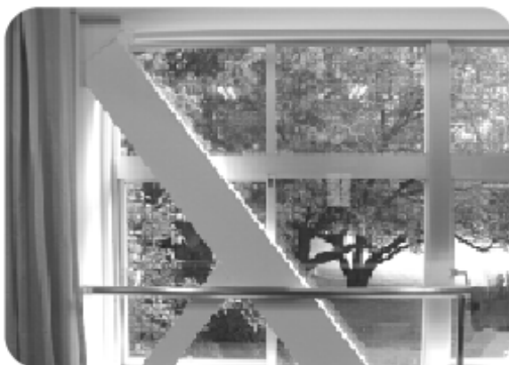
耐震化が完了した2小の教室
