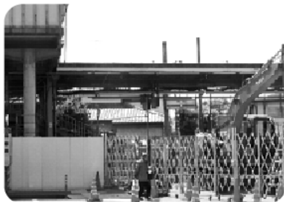
建設が始まった矢川駅エレベーター
